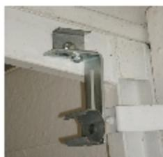
Achtung: Berlin 14 - Befestigung der Laufschienenabhangung ohne Spannklaue direkt am Rechteckrohr. Der Querriegel wird wieder als Abstandhalter am Laufschienenende eingebaut.
